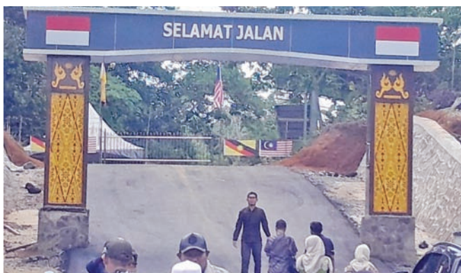
PERBATASAN : Kondisi PLB Temajuk yang ada di Kecamatan Paloh. PLB ini menghubungkan Desa Temajuk Indonesia dengan Kampung Telok Melano, Malaysia.
